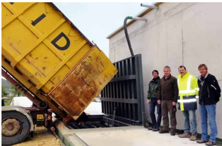
Erstbelieferung der Hackschnitzelheizung
